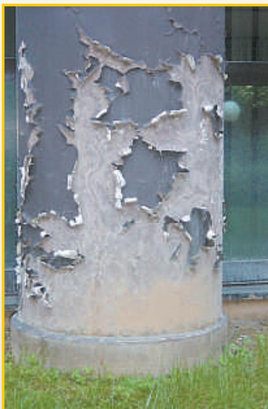
**Esfoliazione della pellicola di rivestimento causata dall'utilizzo errato di un materiale sintetico impermeabile.**
