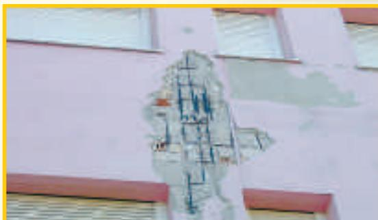
**Struttura in cemento armato con ferri d'armatura scoperti e deteriorati dai sali.**
